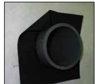
防水ゴムシートがセットされた状態
